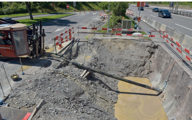
Spülbohrung Rastplatz Baltenswil Süd
