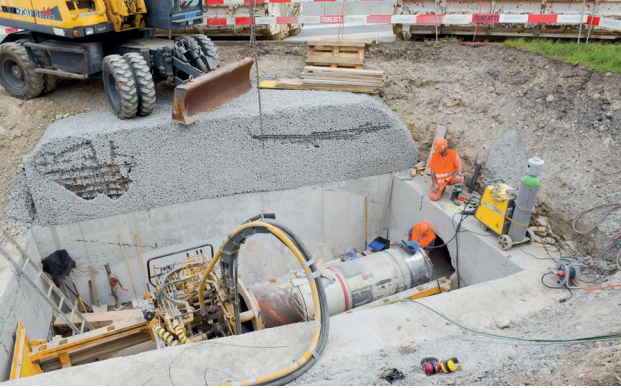
Hydraulischer Pressbohrvortrieb (Startschacht) Verzweigung Brüttisellen
