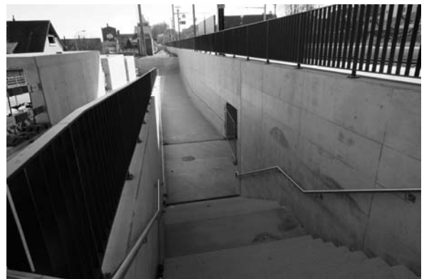
Neue Fussgängerunterführung beim Bahnhof Illnau
