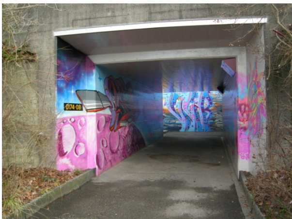
Unterführung Illnauerstrasse, Effretikon
