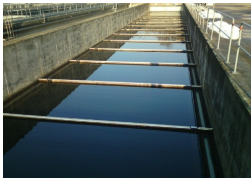
Linkes Bild: Nachklärbecken nach der Demontage des alten Räumers
