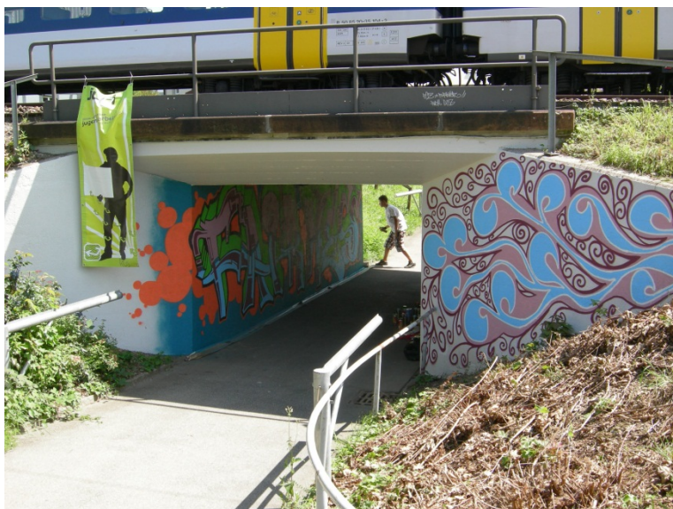
Bahnunterführung Trittlweg, Effretikon
