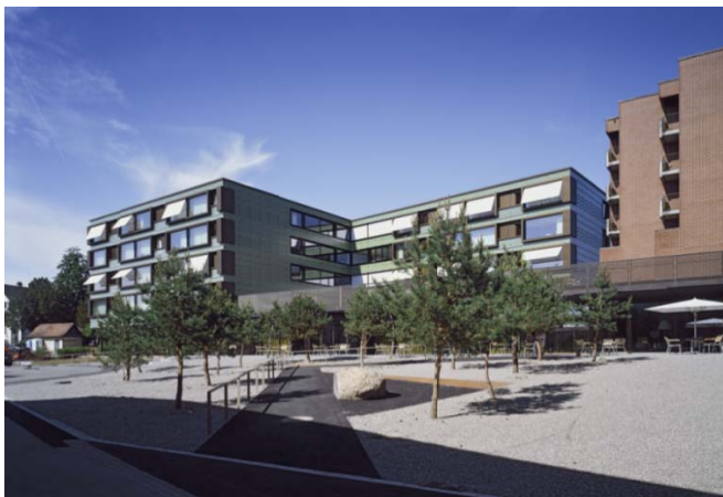
Neubau Alterszentrum Bruggwiesen
