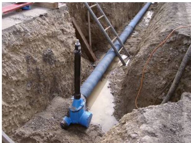
Ersatz der Wasserleitung
