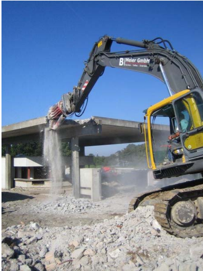
Abbrucharbeiten beim Kassenhaus, Sportzentrum Eselriet
