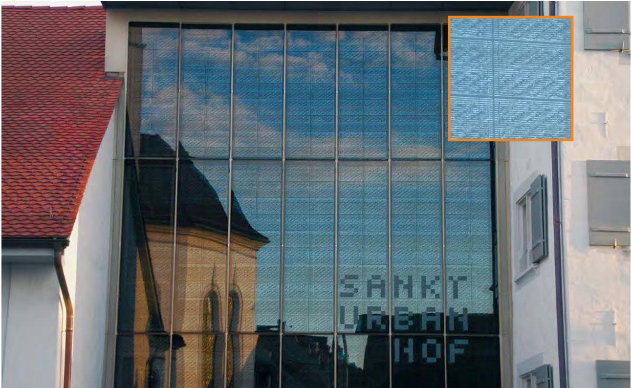
Neu errichteter Verbindungstrakt zwischen zwei historischen Gebäuden. Dieser Glastype spiegelt zwar relativ stark, doch wird die Scheibenvordring durch die flächige Musterung und den Schriftzug gut erkennbar.
