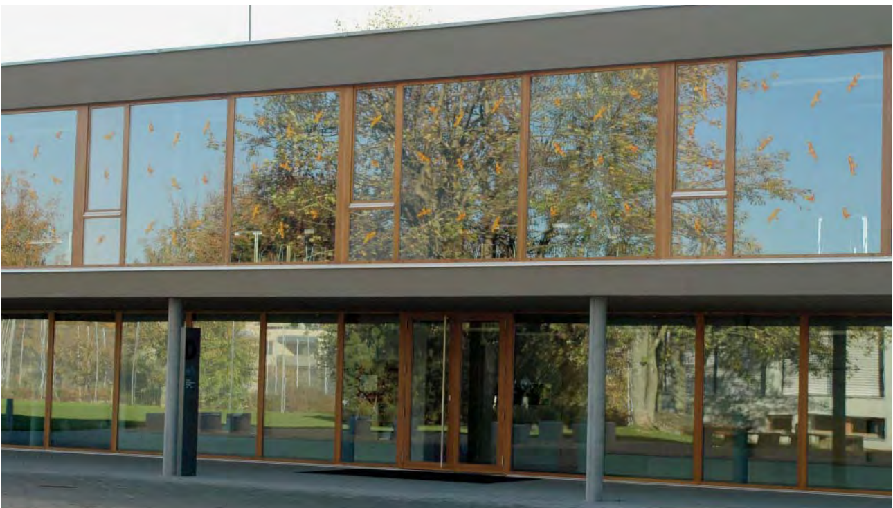
Ein Schulhaus-Neubau mit einer breiten, zweigeschossigen Glasfront. Wegen des eingesetzten Glases mit hohem Reflexionsgrad kam es dauernd zu Kollisionen. Die farbigen Silhouetten wurden von den Schülern und den Biologielehrern in einer «Verzweiflungstat» angebracht. Die Kollisionsgefahr wurde damit etwas gemildert, doch das Problem ist weder ästhetisch befriedigend noch wirklich wirkungsvoll behoben.
