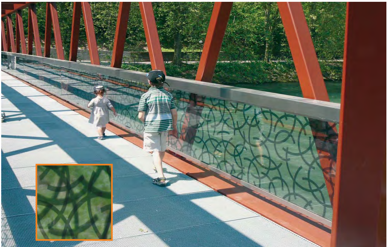
Realisiert wurde schliesslich dieses Dekor aus Kreissegmenten, die noch leicht transparent sind. Es wirkt einerseits elegant und beschwingt. Andererseits schliesst sich das Dekor aus dem Blickwinkel des anfliegenden Vogels zu einer Art «Kettenhemd» und ist für ihn vermutlich gut erkennbar.
