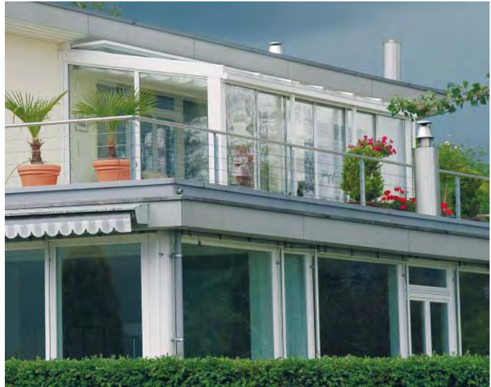
Wintergarten, verglaster Wohnbereich
