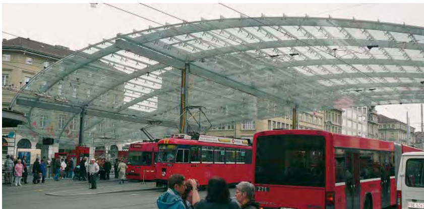
Solche gläserne Überdachungen sind weitgehend unproblematisch. Ein Restrisiko besteht möglicherweise an den Rändern, die stärker geneigt sind. Dank einem flächigen Punktraster, das zudem den Passanten einen gewissen Blendschutz bietet, ist auch diese Gefahr behoben.
