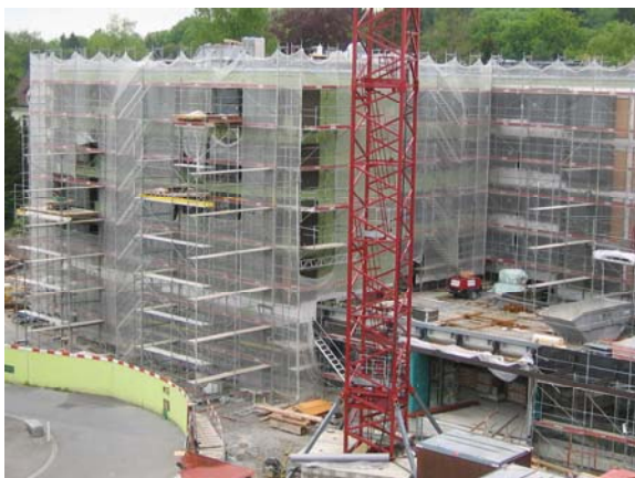
Der Baufortschritt in Bildern
