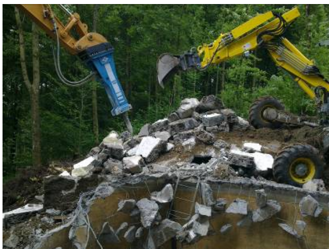
Demontage des Reservoirs Hackenberg
