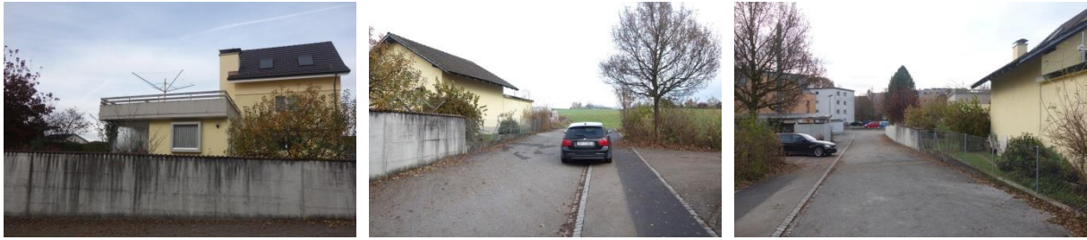
Abbildung 21: Erschliessungsstrasse, Wohnhaus (Nr. 1128) und Garage (Nr. 1129)
