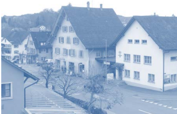
Dorfzentrum Illnau mit Häusern Usterstrasse 23 / 25
