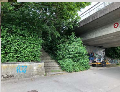
Treppe Hinterbühlstrasse/ Illnauerstrasse
