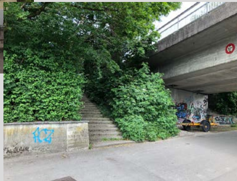
Treppe Hinterbühlstrasse/ Illnauerstrasse
