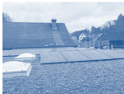
Neue PV-Anlage auf dem Dach des Rest. Rössli
