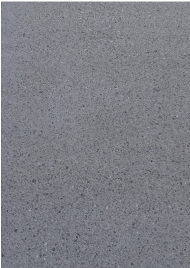
Fahrbahnbelag – Beton asphaltgrau
