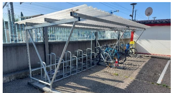
Abbildung 3: Zwei einseitig nutzbare Unterstände (nicht verschraubt), Foto: Stadt Illnau-Effretikon
