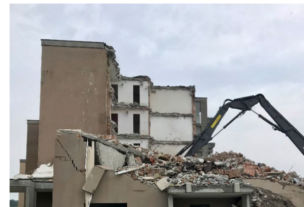
Abbruch der Wohnbauten an der Rütlistrasse
