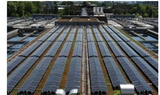
Begrüntes Dach mit 18 bis 40 cm Aufbauhöhe (tiefste vs. höchste Stelle), System „Sunballast Ballast ECKE 10“
