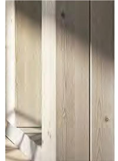
2. Ebene: Die neue Fassade im Teilbereich 1 setzt sich bewusst vom Bestandssockel ab mit einer Druckimprägnierung samt heller Lasur der vertikalen Holzstättung.
