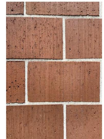
Re-Use: Die Fassade der Aufstockung im Teilbereich 2 wird mit den Abbruchziegeln des Teilbereiches 1 gemauert.
