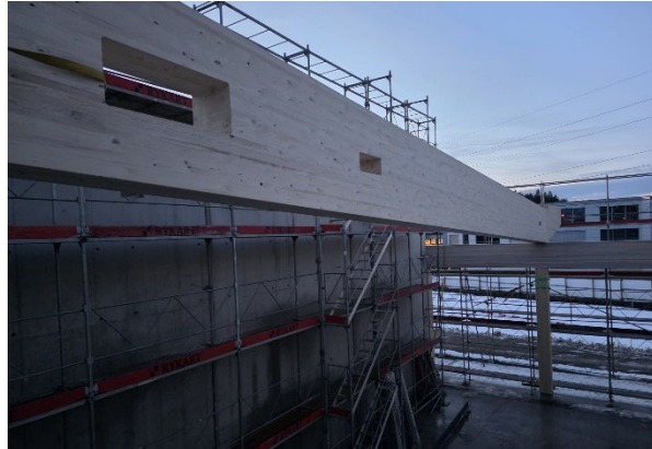
Neubau Feuerwehr- und Werkgebäude
