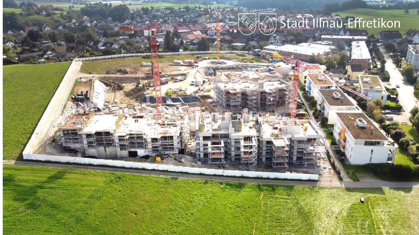
Baufortschritt Wohnüberbauung Hagenbüel, Illnau
