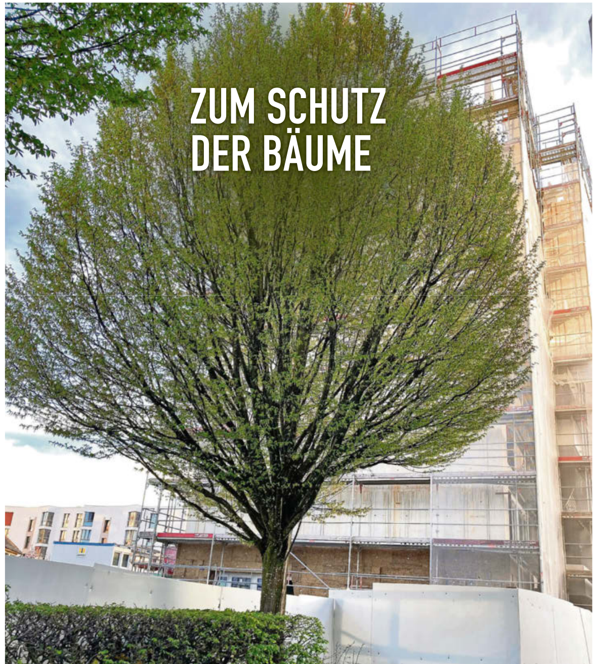
Auf Baustellen sind Bäume stets stark unter Druck. Es reicht nicht, neben dem Stamm eine Schutzwand hinzustellen. Der ganze Wurzelbereich unterhalb der Krone muss geschützt werden. Foto: Barbara Leuthold Hasler
