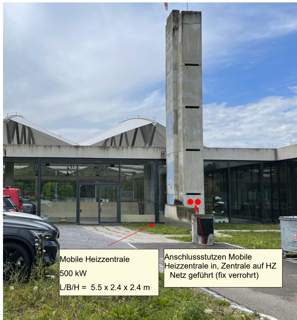
Abbildung 16: Standort der Mobilen Heizzentrale
