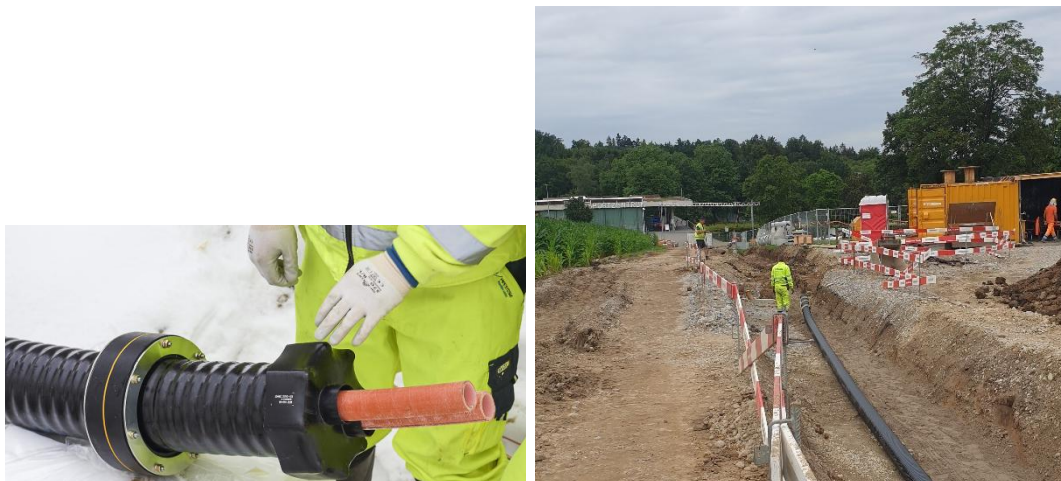
Abbildung 25: Links: Beispielbild Calpex PUR King DUO (Brugg Pipe Systems), rechts: Verlegung der Fernleitung in der Eselrietstrasse.
