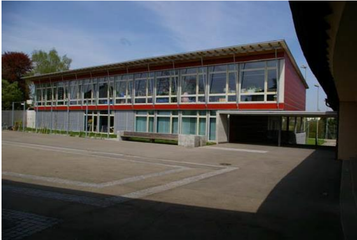
Schulanlage Hagen im Minergie-Standard
