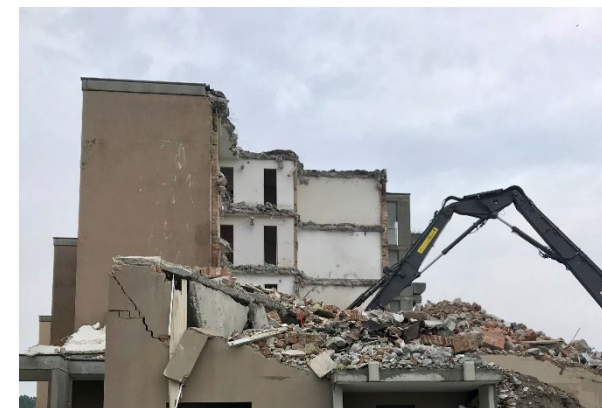
Abbruch der Wohnbauten an der Rütlistrasse
