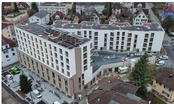
Bahnhofplatz: Übersichtsfoto vom Dezember 2024 Verfasser: Bereuter Totalunternehmung AG
