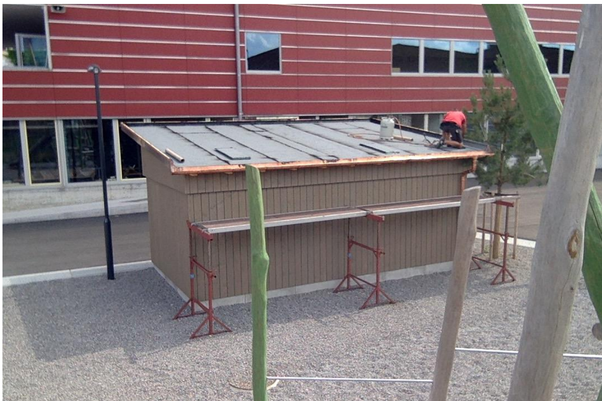
Der Kiosk bekommt ein wasserdichtes Dach
